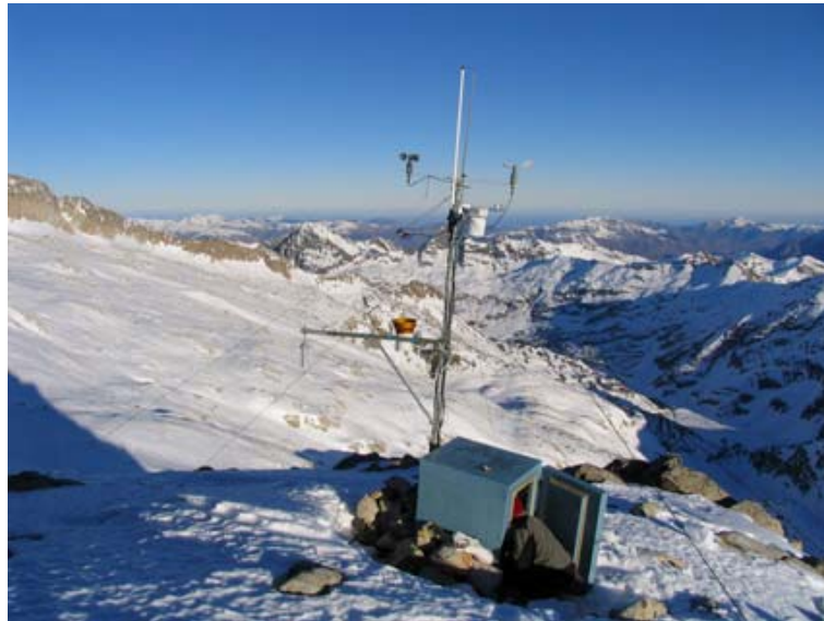
Fig 2 : vista general de la estación y torre de aparatos.
